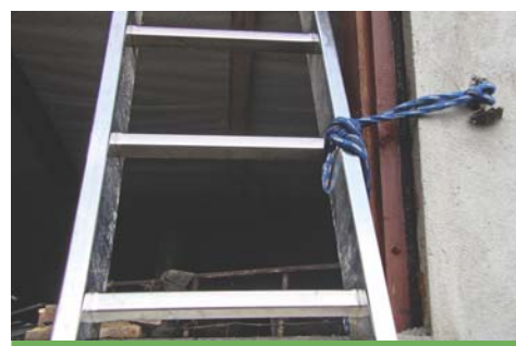
Zabezpieczenie górnej części drabiny przez przywiązanie do elementu stałego.
